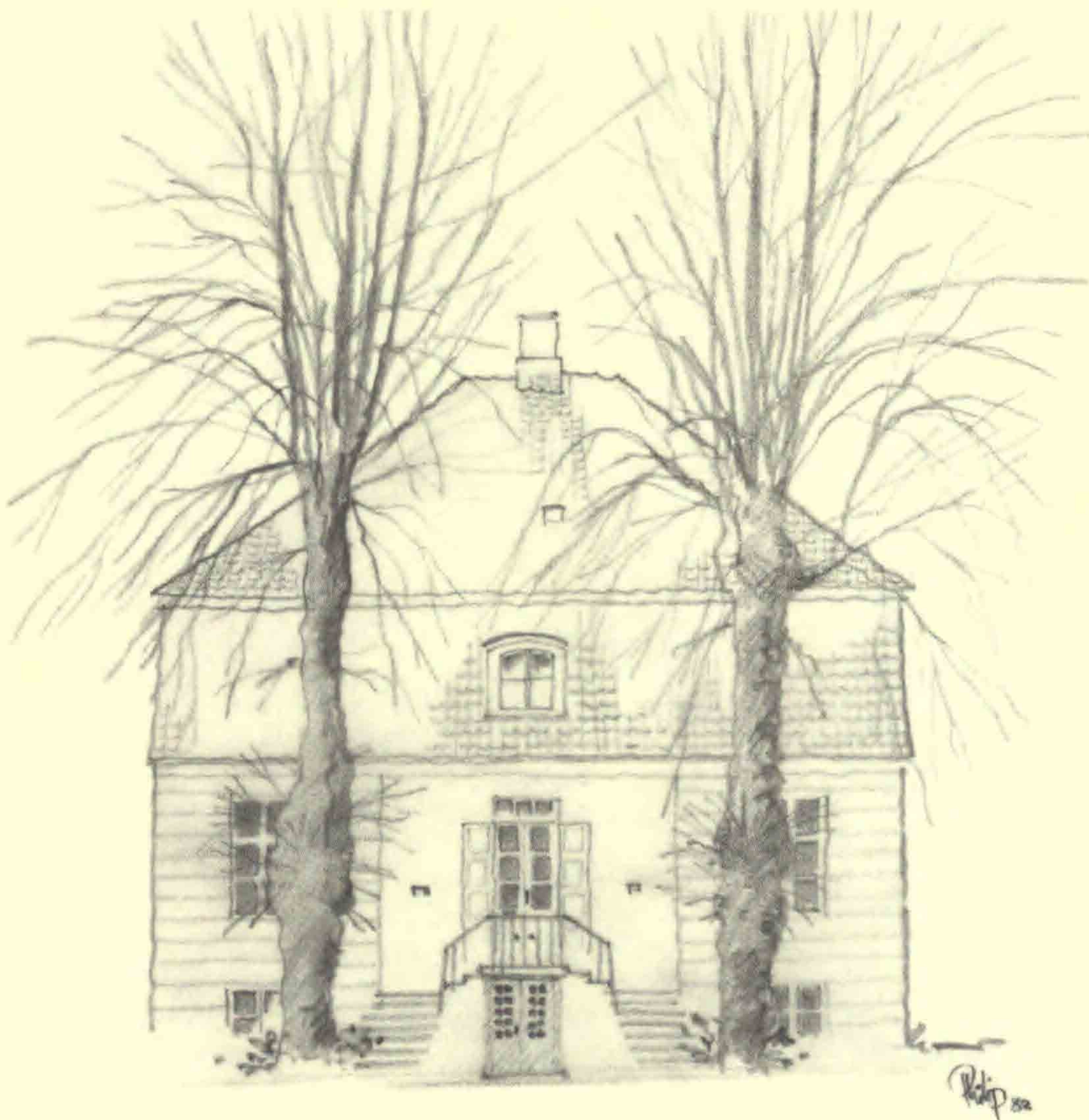
Den fredede hovedbygning til gården »Rolighed« fra midten af 1700-tallet med to stynede parklinde set fra gårdspladsen.
