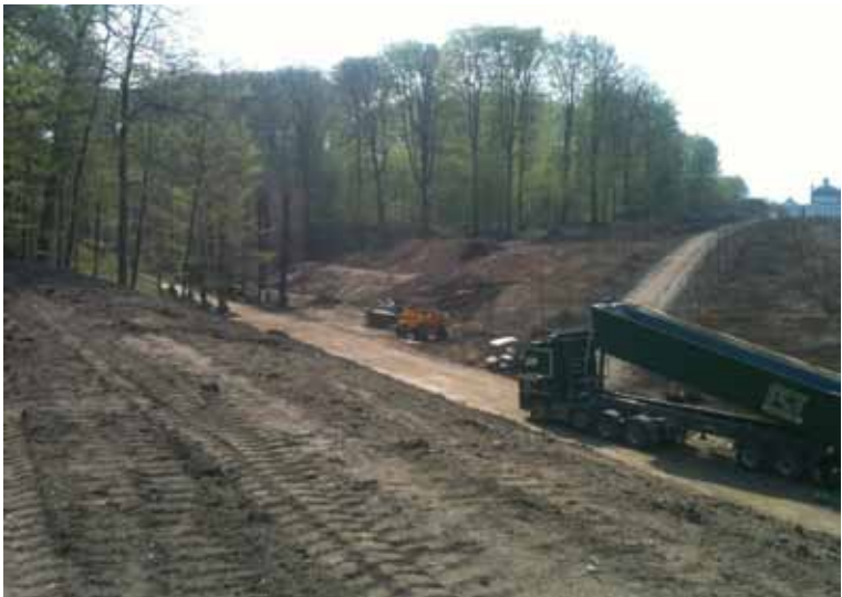
Jordarbejde skaber niveauforskel. Foto Schønherr.
