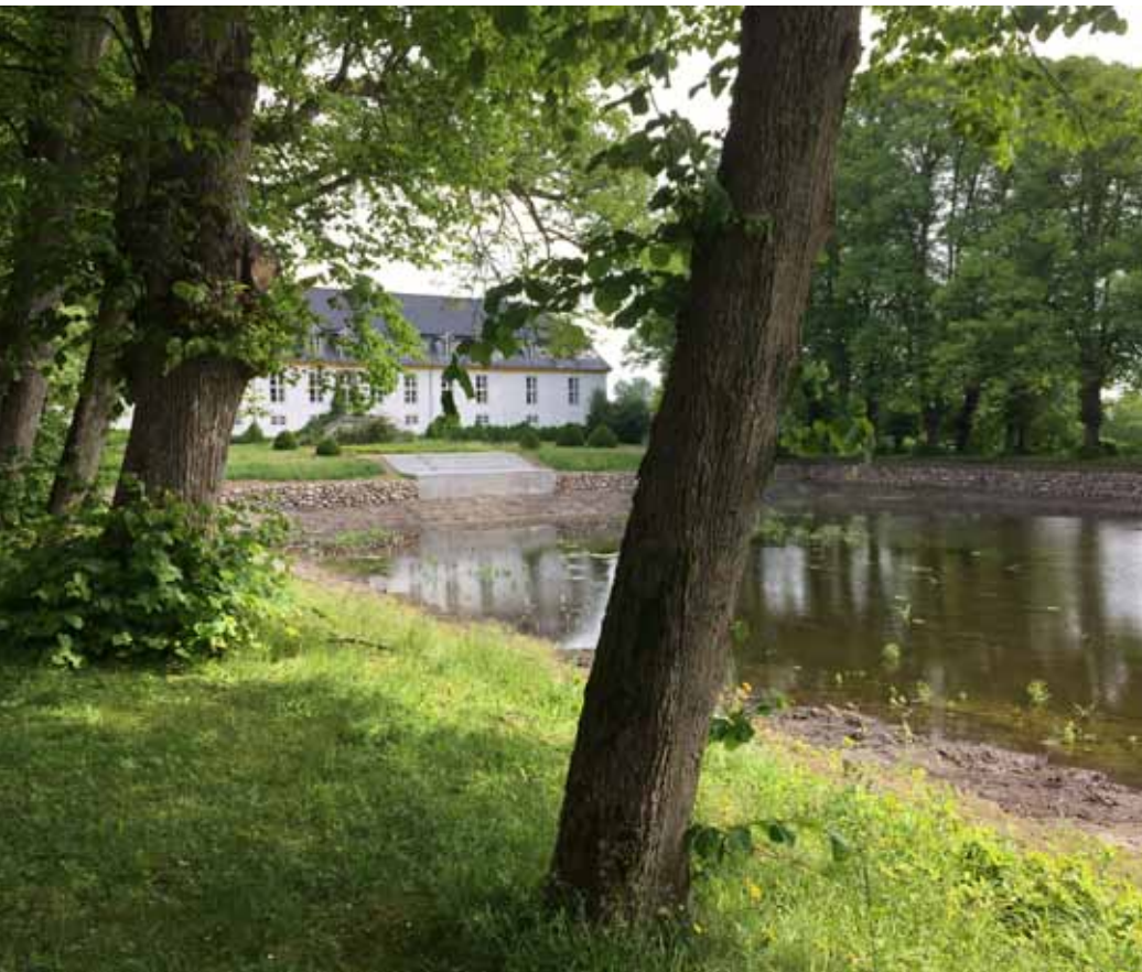
Fotos fra forsommeren 2017. Spejlbasinnet er under renovering. Stensætningen genskabes mens hovedtrappen i in-situ-beton er en nutidig fortolkning af det gamle anlæg.
